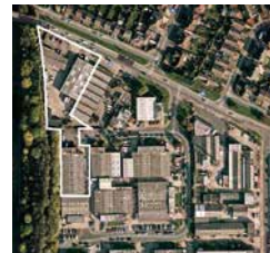
Der Power Towers-Standort in Leicester, GB.
